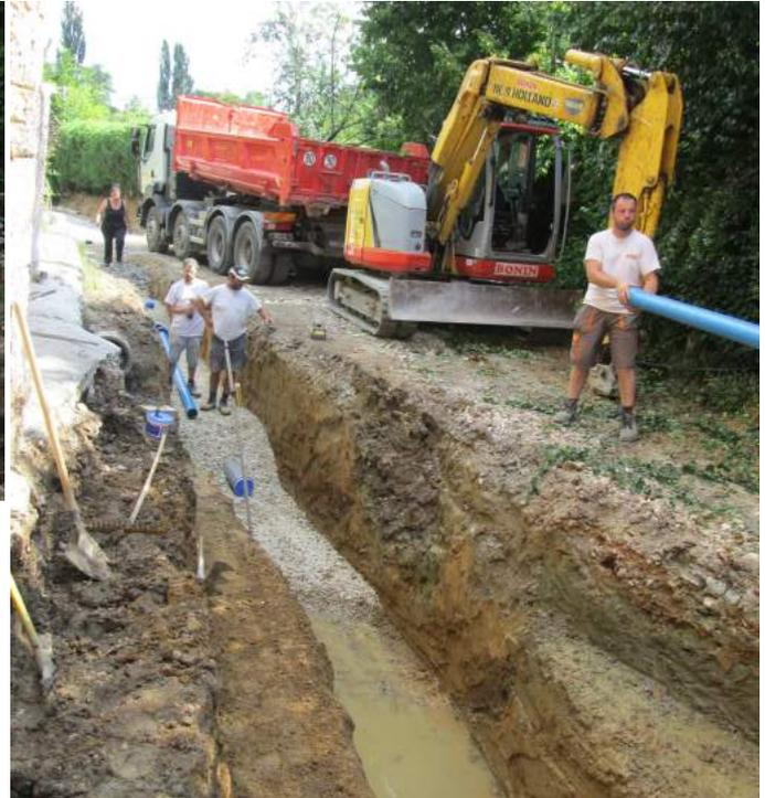
La collecte des eaux usées et le raccordement à l'eau potable est maintenant terminé. La structure de la chaussée ayant été déstabilisée, la route principale, les annexes et leurs bas côtés ont été repris en enrobé ou en Balthazar.
